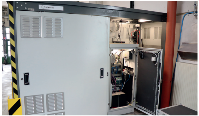
Der Schaltschrank und das Kühlsystem sind in einem Gehäuse vorinstalliert.
